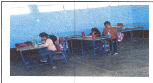
Foto 4: Sustitución de piso por ceramico
