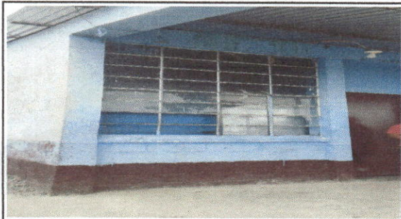
Foto 3: Mantenimiento de estructura de metal ventanas.
