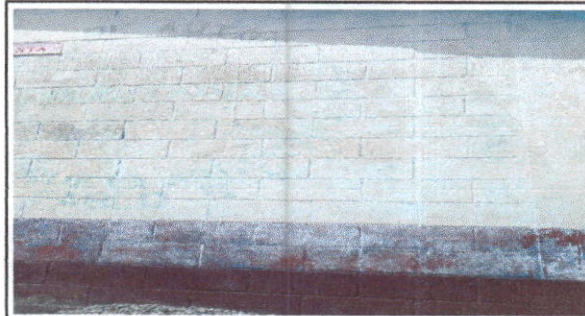
Foto 2: Pintura en muros exteriores e interiores
